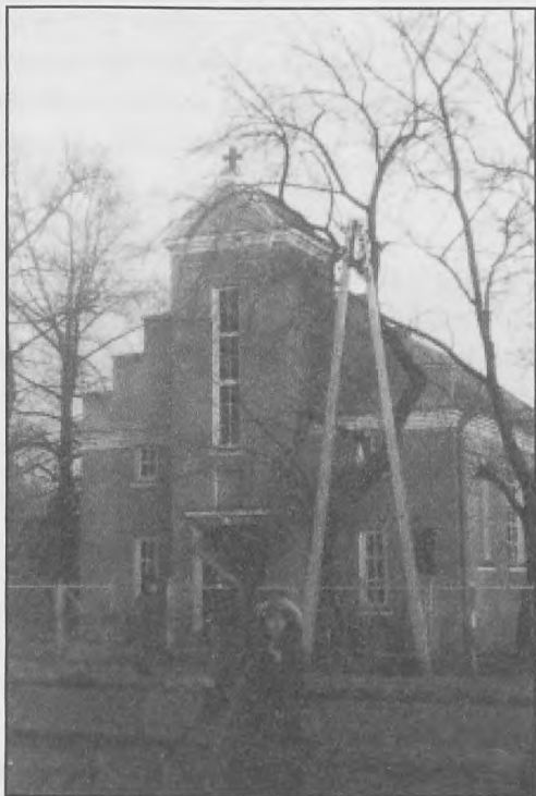
Fotografia kościoła garnizonowego przy ul. PZPR (Piłsudskiego), lata siedemdziesiąte
