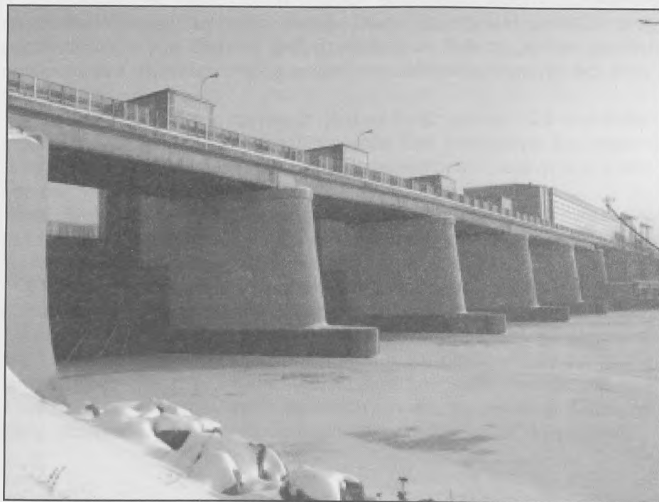
Pięcioprzęsłowy jaz zapory w Dębem
