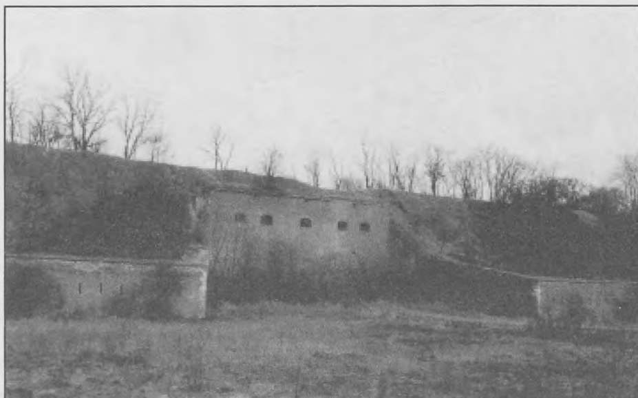
Widok na bramę z działobitnią Frontu Parysów (obwód zewnętrzny)
