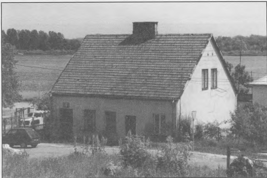
Dom przy ul. Niskiej 1. Jego pierwotną konstrukcję drewnianą wtórnie obudowano ceglami
