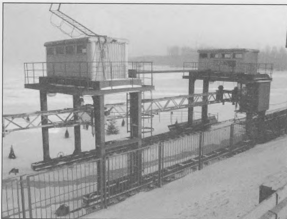
Urządzenia dźwigowe części ziemnej
