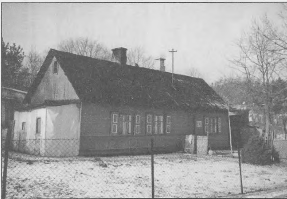
Dom wielorodzinny przy ul. Retmańskiej 57
