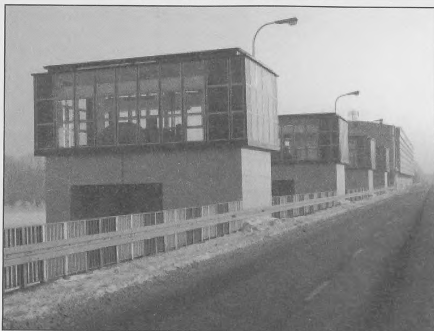
Wieże mieszczące mechanizmy podnoszenia i opuszczania jazów. Obok droga publiczna
