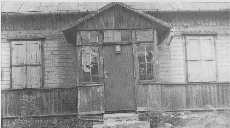
Fot. 5. Front domu z wejściem. Werandka wejściowa była oszklona dookoła kolorowymi szybkami. Oryginalnie drzwi wejściowych na werandę nie było (istniały tylko drzwi z werandy do sieni). Te widoczne na zdjęciu zostały założone podczas naszego (mojego i żony) krótkiego zamieszkiwania w latach 1969 – 1971. Widoczne są, zamknięte okiennicami, okna do kuchni w obu mieszkaniach
