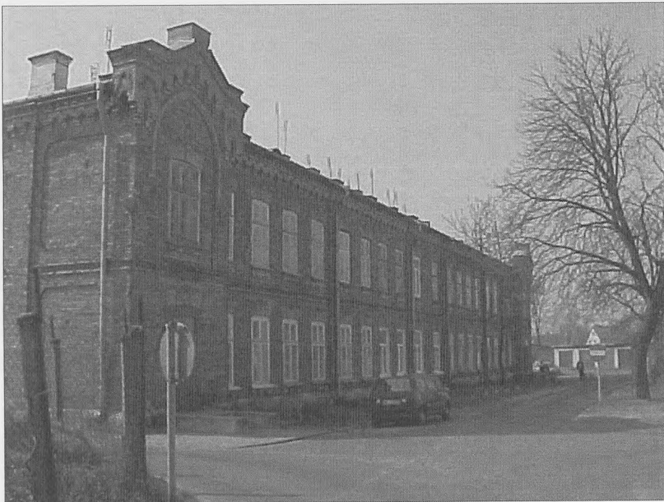
Budynek przeznaczony na zakwaterowanie kadry 1. pułku (stan obecny). Zdjęcie M. Pakuła
