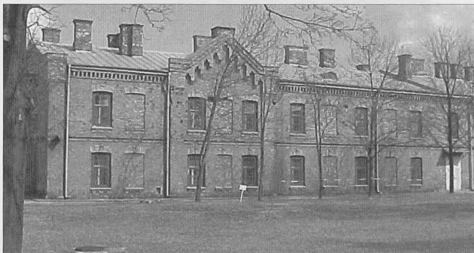
Budynek przeznaczony na zakwaterowanie żołnierzy służby zasadniczej 1. pułku (stan obecny). Zdjęcie M. Pakuła
