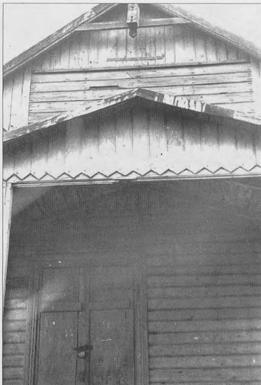
Fot. 4. Widok od strony szczyto- wej (północnej). Widoczna resztk werandy letniej z drugiego miesz- kania oraz drzwi z pokoju. Na poddaszu widoczny jest podłużny otwór w desce po lornecie nożycowej, o której wspominam w tekście
