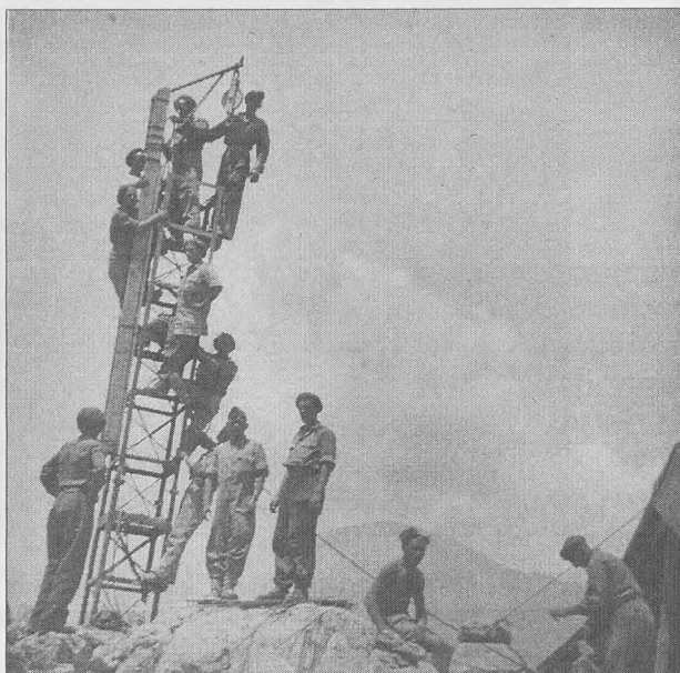
Fot. 35. Montaż podnośnika do wciągania kolejnych elementów krzyża. Na samej górze z lewej strony – kpr. T. Szklarek. W tle widoczna góra Cairo
