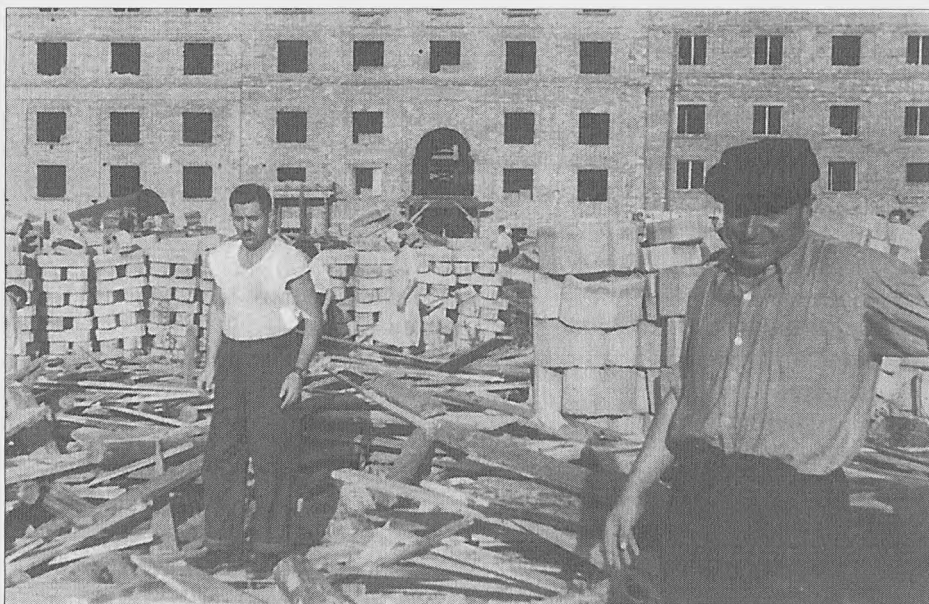
Antoni Nowicki (z lewej) przy odbudowie warszawskiego Śródmieścia po wojnie
