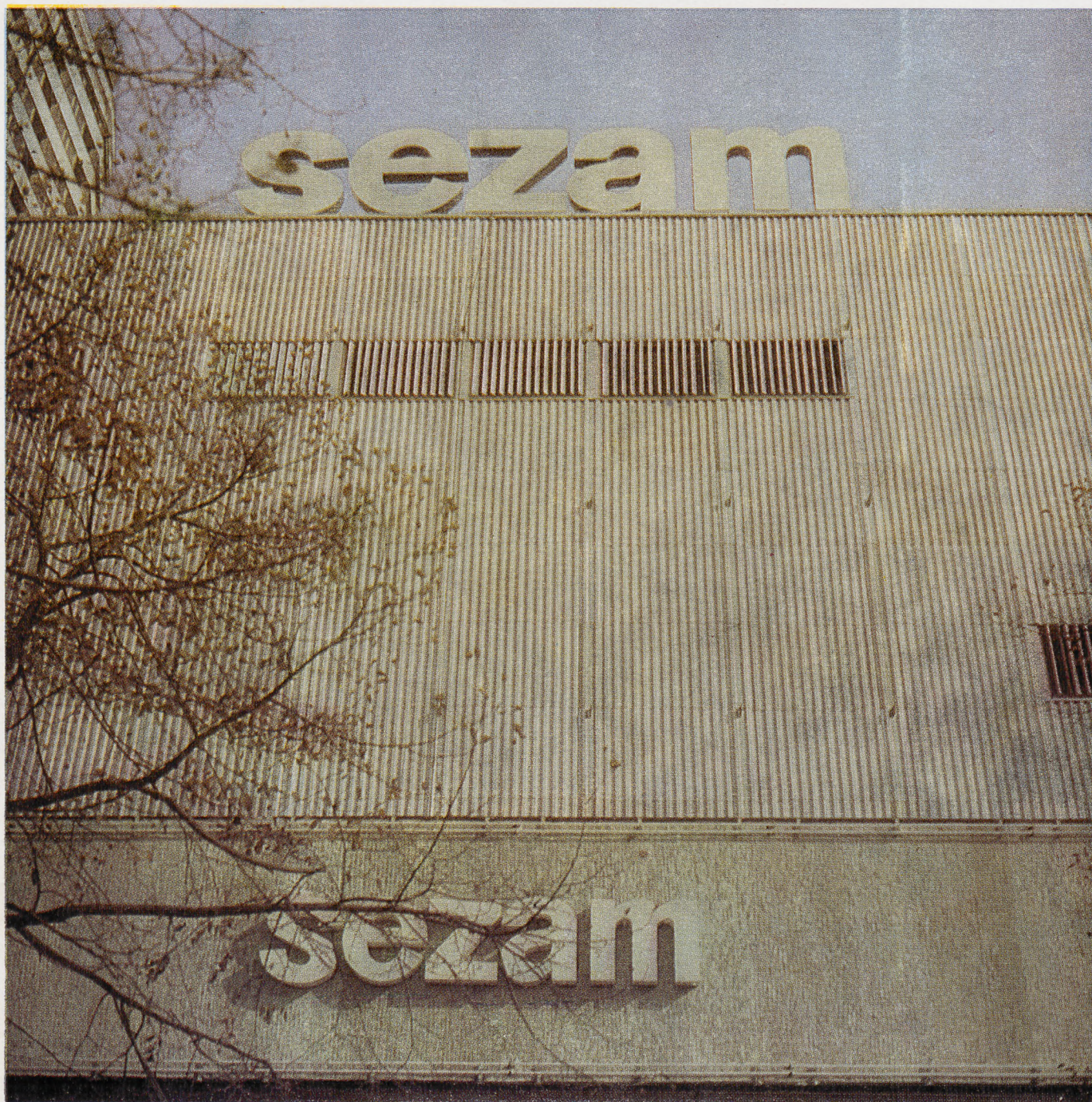
6 Fragment elewacji zachodniej „Sezamu”. Widoczna ściana kurtynowa
