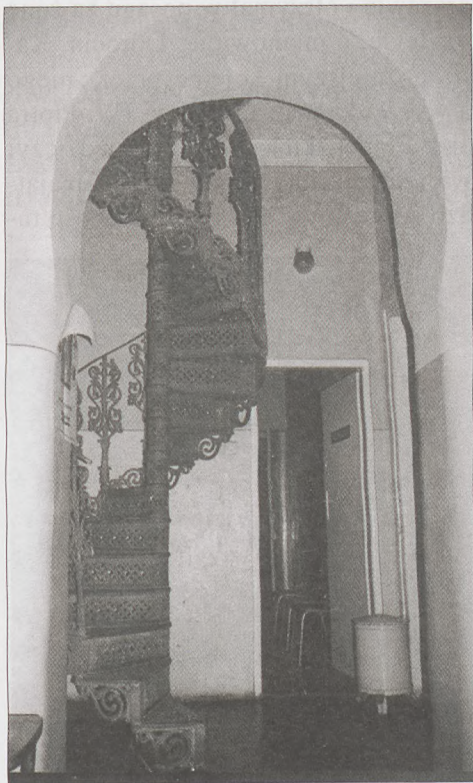
24. Żeliwne schody wewnątrz dworu
