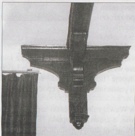
33. Belka stropowa na piętro
