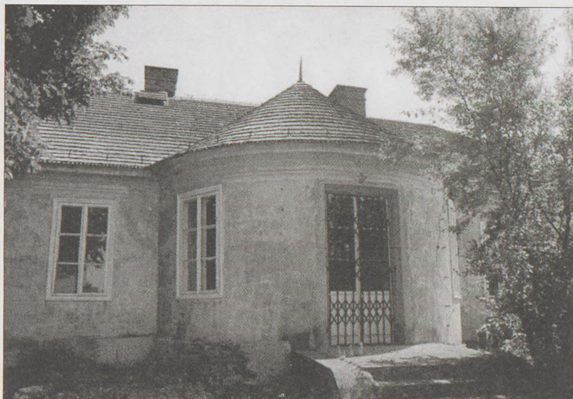
39. Półkolisty ryzalit od strony ogrodowej
