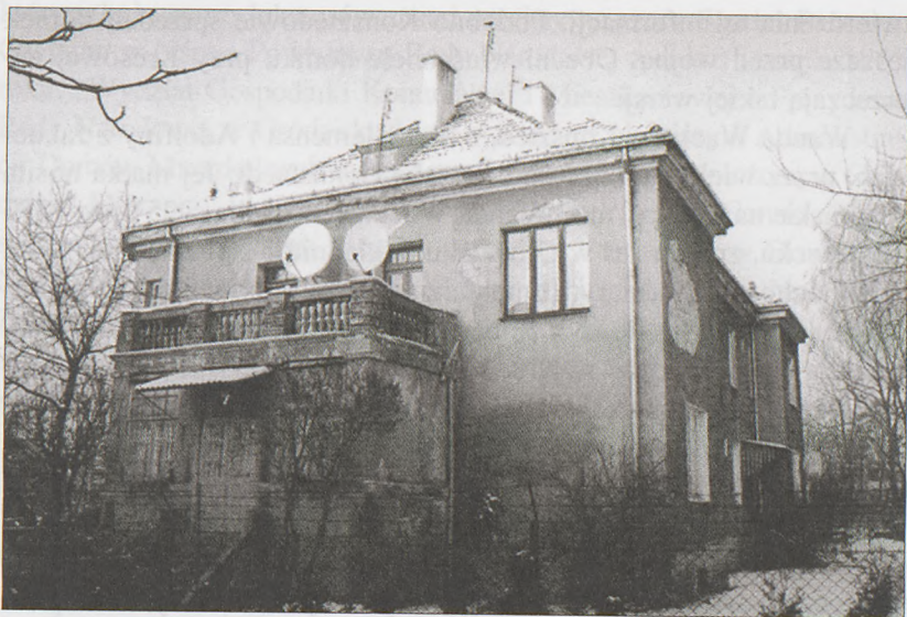
3. Elewacja od strony północnej
