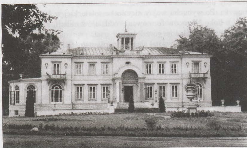
37. Elewacja wschodnia, 1956 r.
