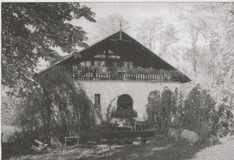
78. Dwór od strony południowej
