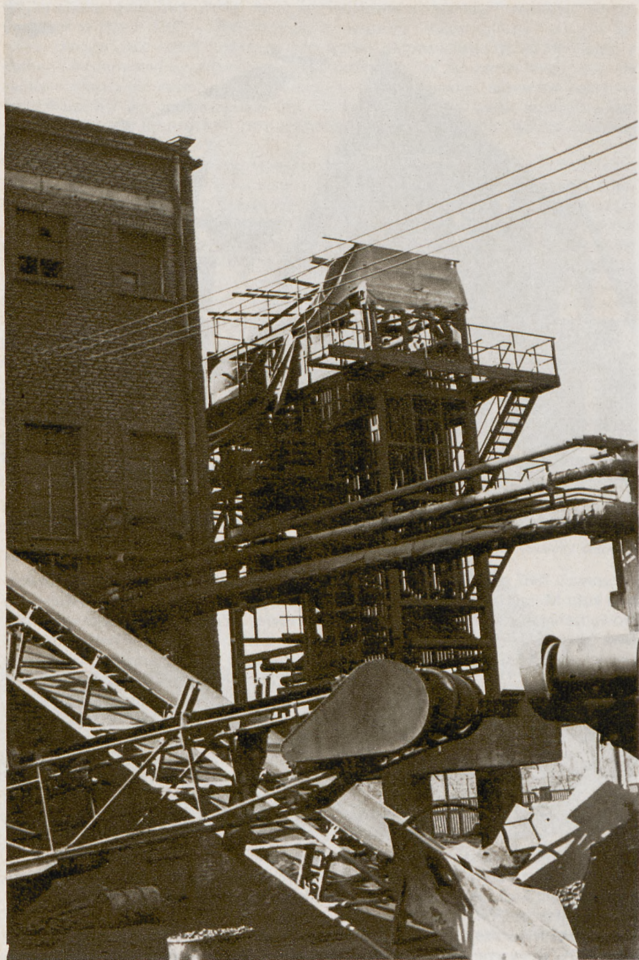
Kotłownia mechaniczna w rozbudowie.
