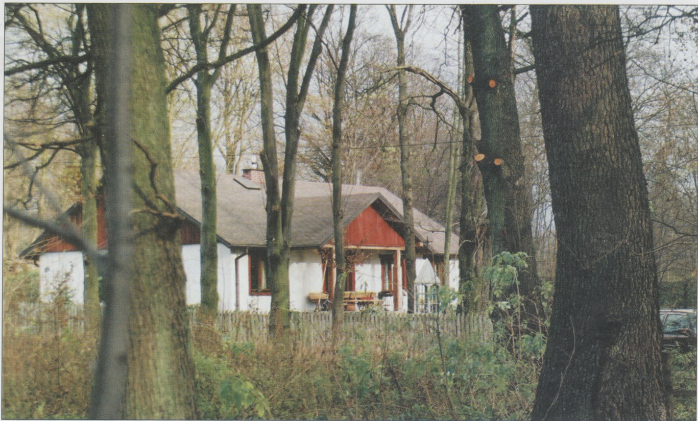
Nowy budynek w miejscu starego świetnie wkomponowany w otoczenie i nawiązujący do architektury pobliskich dworców
