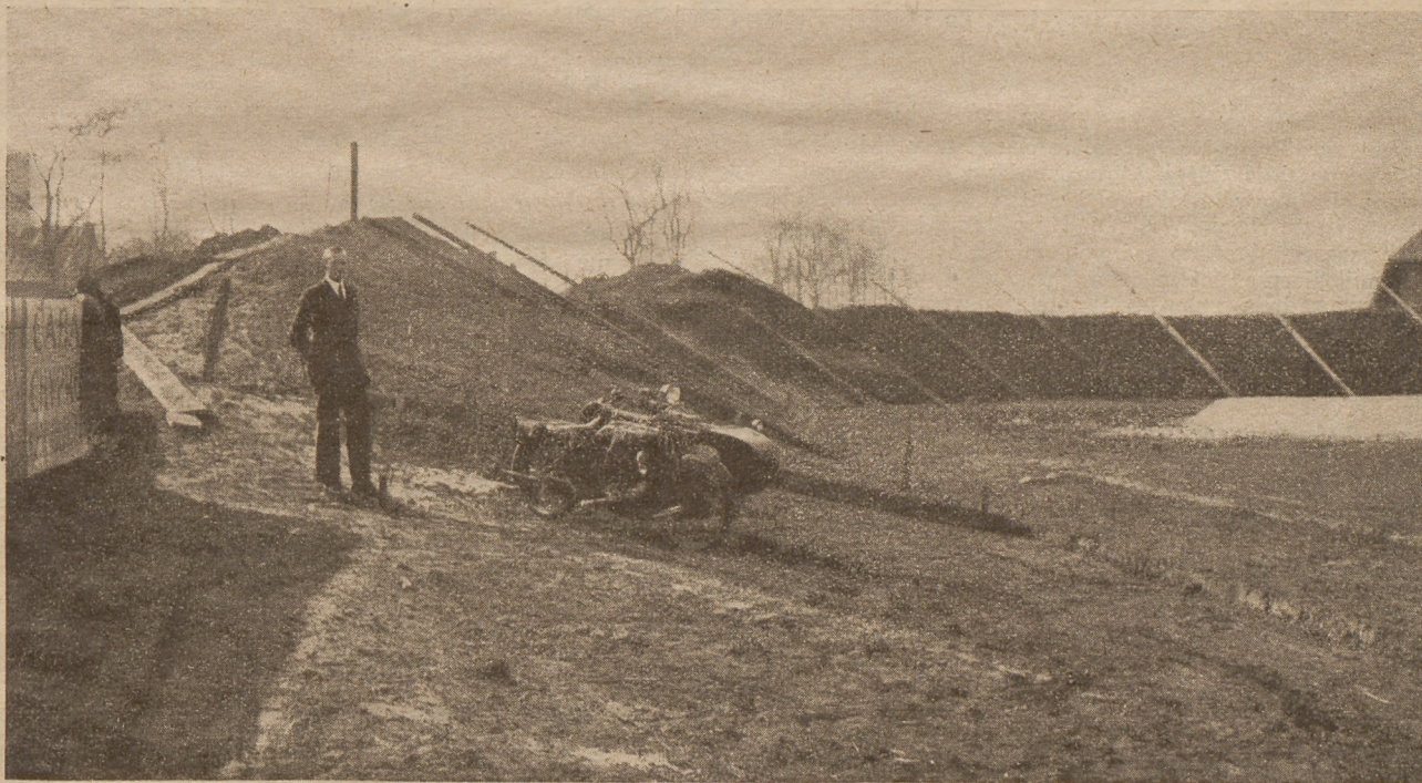
Łazarski, mistrz Polski w sprincie, dogląda budowy toru kolarskiego Cracovii, której jest członkiem.
