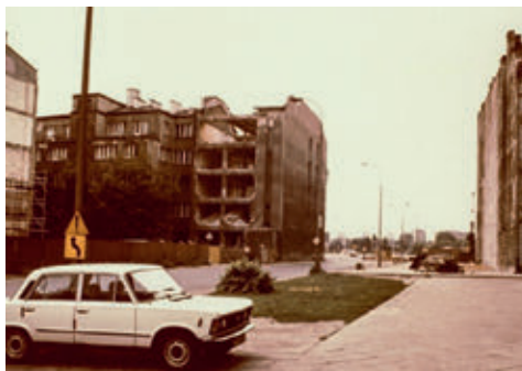
Lata 1982-85. Mieszkanie przy ul. Jaworzyńskiej (rejon dzisiejszej stacji metra Politechnika). Jeden pokój, mała kuchnia, toaleta z wanną, gaz oraz ciepła woda.
