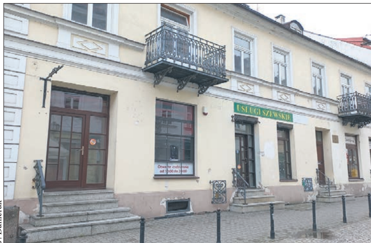
Rozpoczyna się przebudowa kamienicy przy ul. Grodzkiej 8
