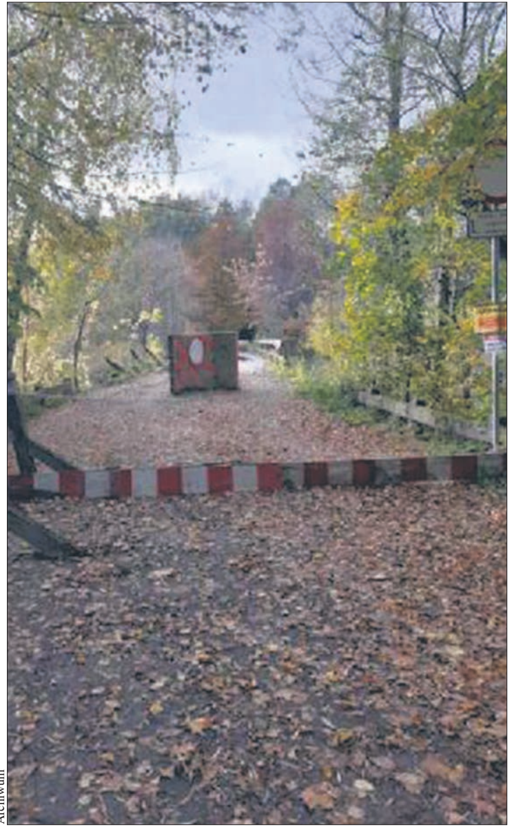
Od 2019 roku most na Skrwie jest zamknięty
