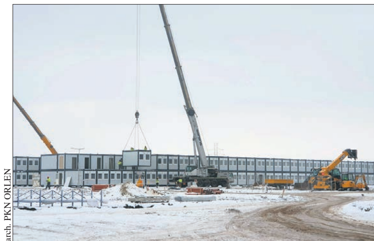
Powstaje miasteczko dla pracowników zatrudnionych przy budowie instalacji Olefiny III
