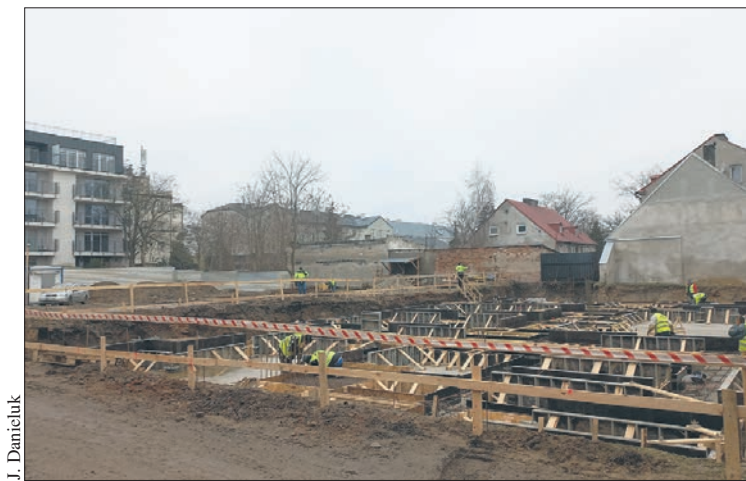
Przy ul. Sienkiewicza 21 powstają już fundamenty pierwszego budynku, w którym znajdą się mieszkania dla seniorów
