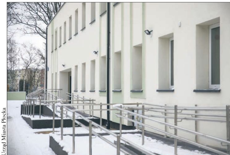
Zakończył się remont placówki opiekuńczej przy ul. Mościckiego
