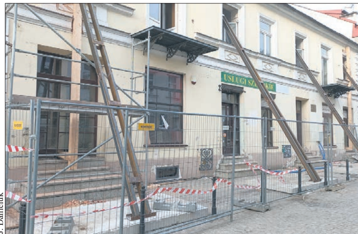
Przy remoncie kamienicy przy ul. Grodzkiej 8 stanęły zabezpieczające podpory
