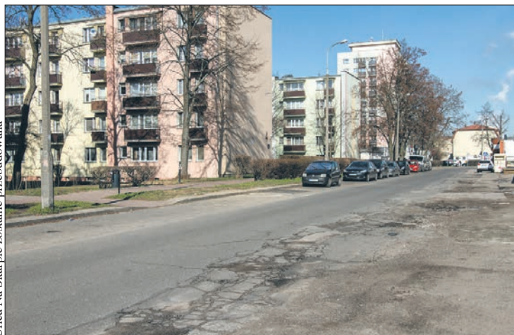
Ulica Na Skarpie zostanie przebudowana
