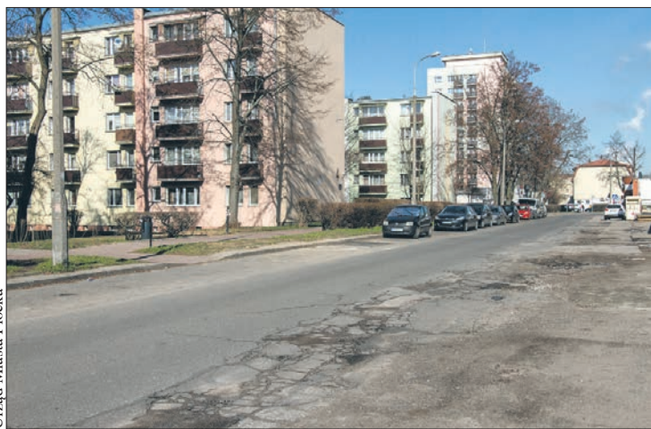
Ulica Na Skarpie zostanie przebudowana
