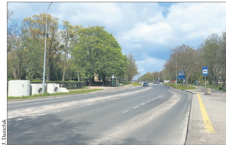
Tuż przed długim weekendem trwały ostatnie przygotowania do rozpoczęcia prac na kolejnym odcinku ul. Łukasiewicza
