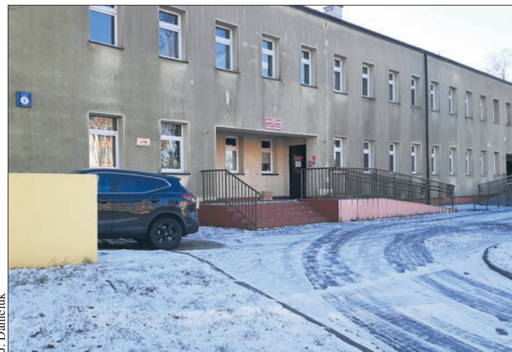
Wkrótce budynek przy ul. Mościckiego 6 zostanie przebudowany
