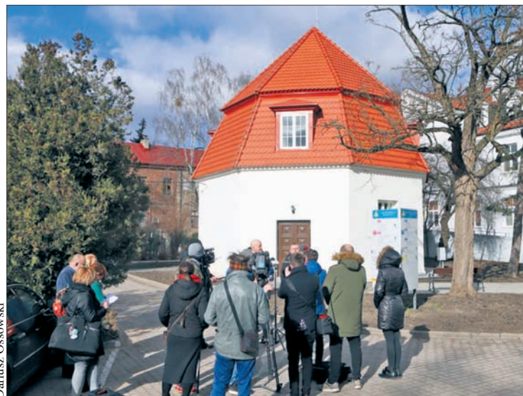
Odnoviony obiekt na terenie Szpitala Św. Trójcy
