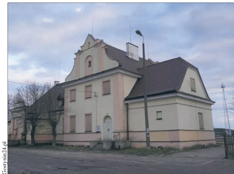
Zabytkowy budynek dworca PKP wymaga remontu
