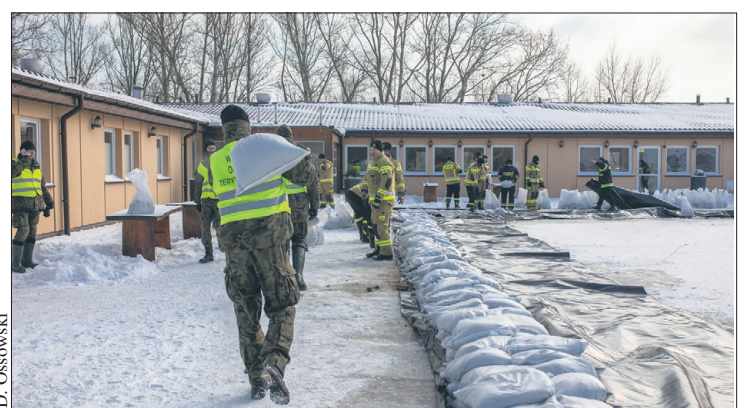
Żołnierze i strażacy zabezpieczali obiekty nad Wisłą
