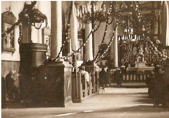
39. Wnętrze kościoła katolickiego w I poł. XX wieku
