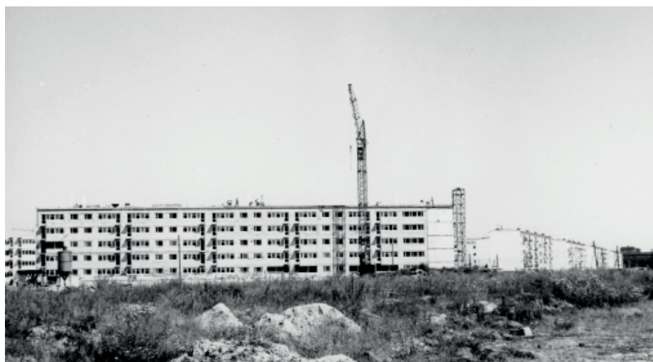
W tle budowa przy ul. Kasprowicza 88 fot. Huta ArcelorMittal Warszawa
