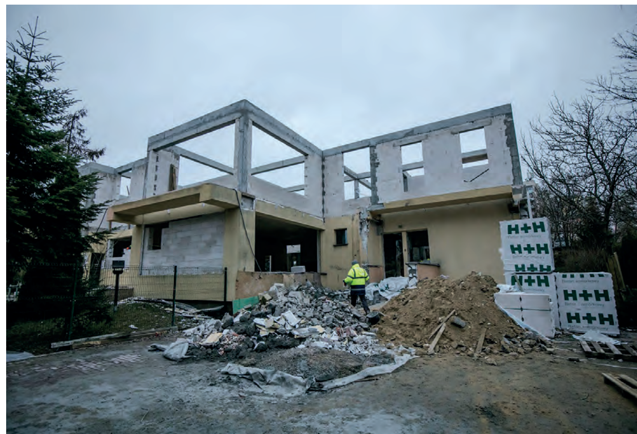
Budowa przy ul. Brązowniczej 17, fol. W. Artyńew
