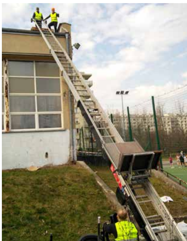
Montaż paneli przy ul. Conrada 6, fot. CRS Bielany
