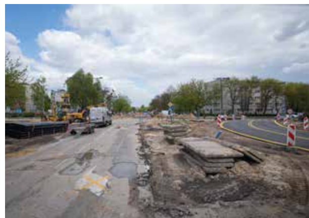
Budowa ronda przy ul. Rudnickiego, fot. W. Artyńew
