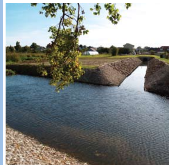
Separator oczyszczający wody opadowe z rejonu ul. Wojska
