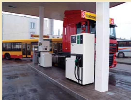
Stacja paliw ZKM
