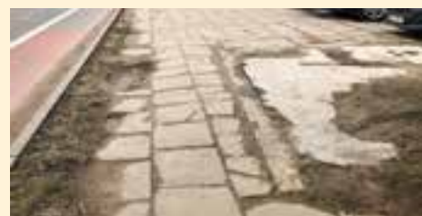
Remont chodnika, ul. Szamoty, fot. W. Sokółowski.
