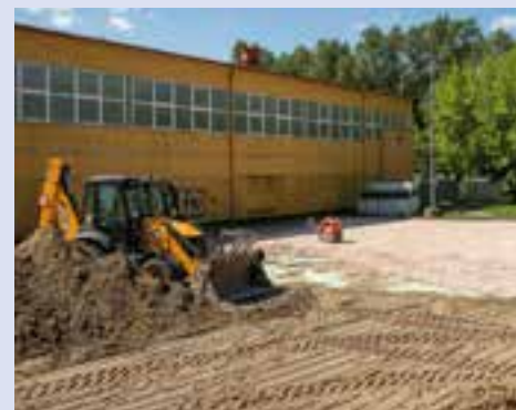
Remont boiska do piłki ręcznej przy SP nr 11, fot. W. Sokołowski.
