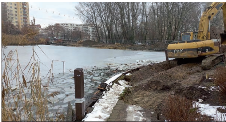
Prace na Stawach Brustmana fot. Zygmunta Morawski
