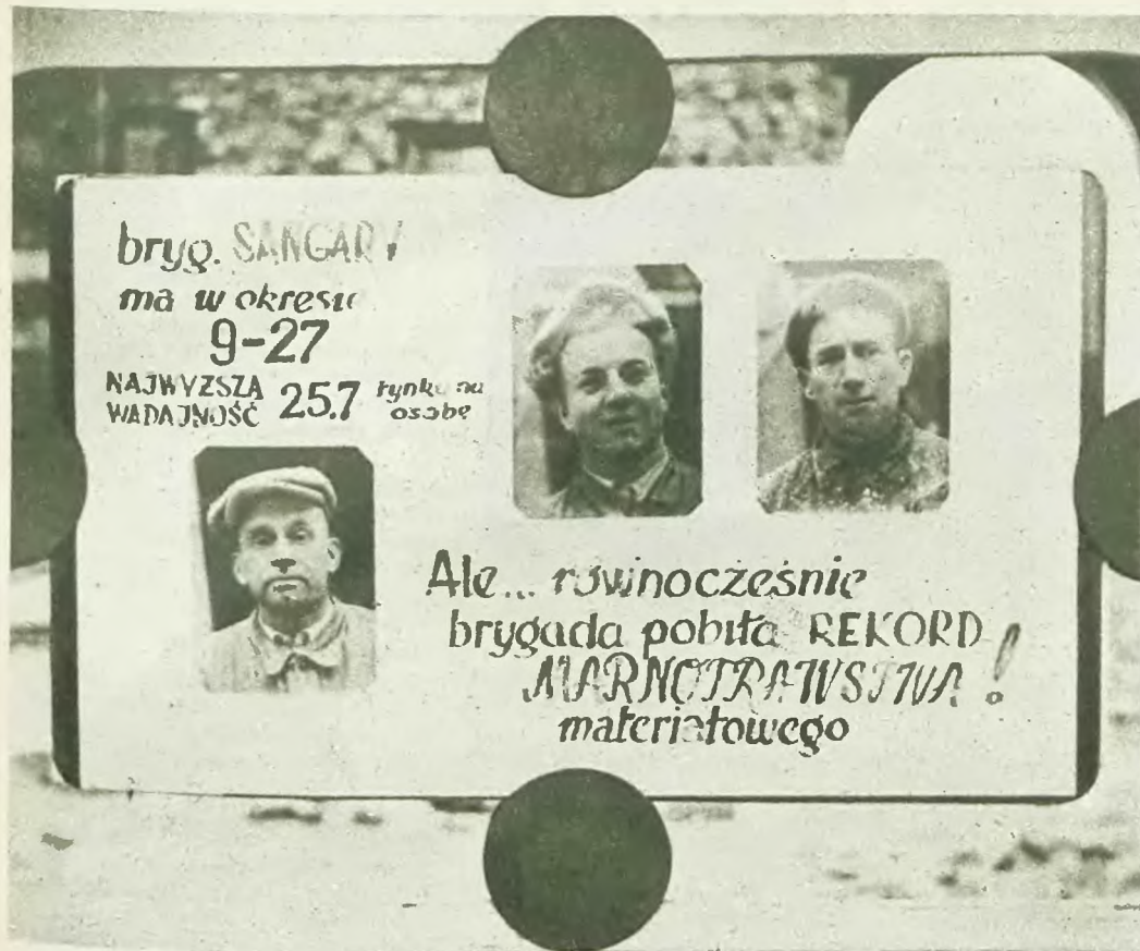
Tablica na budowie „Okraślaka”. Komentarze są chyba zbyteczne, nic dodać, nic ująć...
