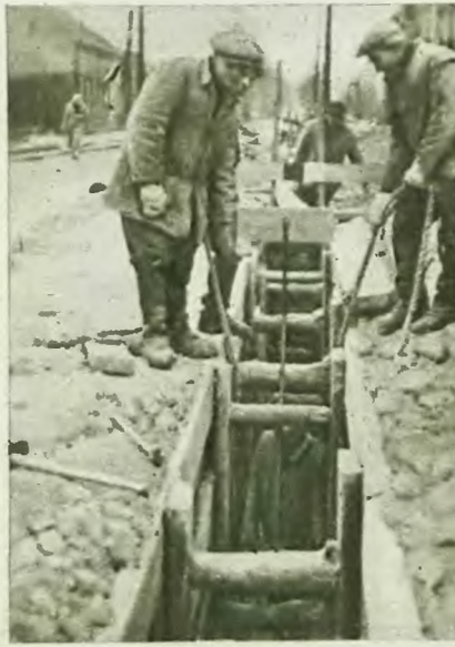
Układanie rur wodociągowych na ulicy Tadeusza Kościuszki we Włochach.
