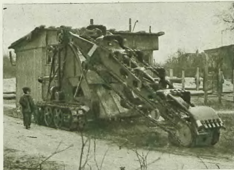
Koparka wąsko-prze-strzenna służy do szybkiego kopania rowów.
