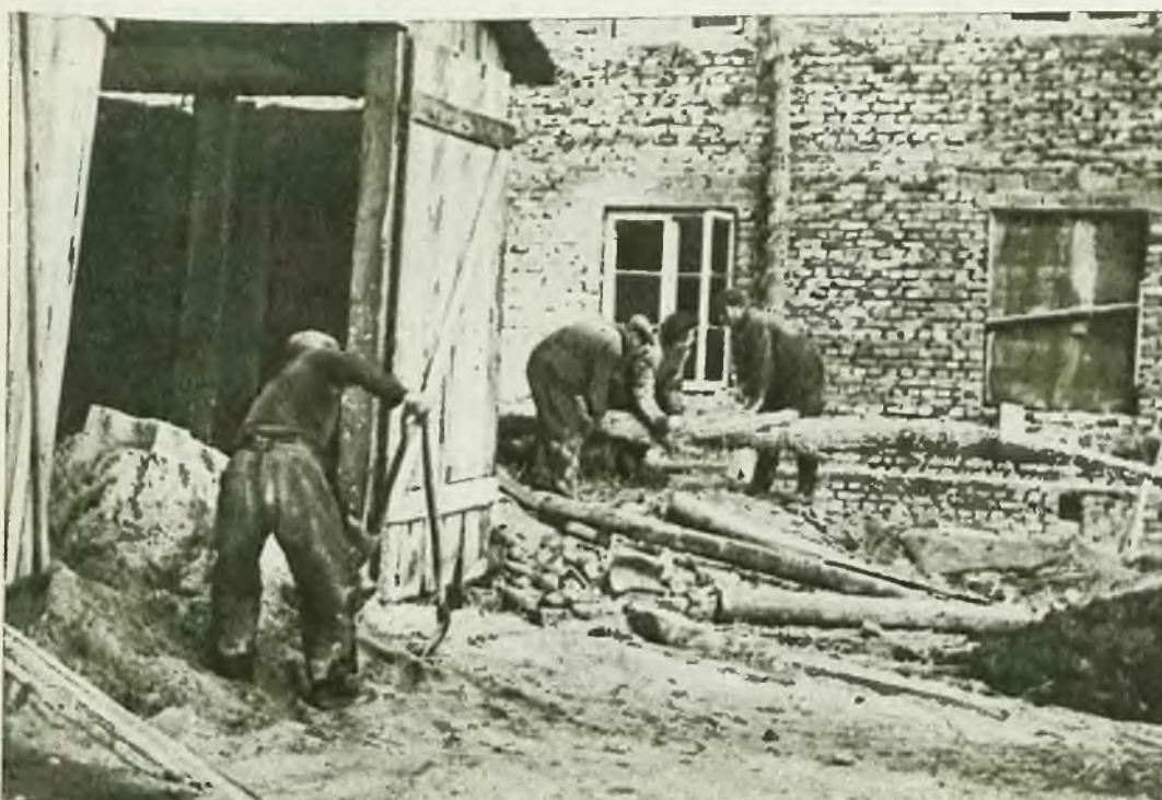
Zaloga „Okraślaka” nie boi się zimy, umie też zabezpieczyć przewody tynkownicy.
