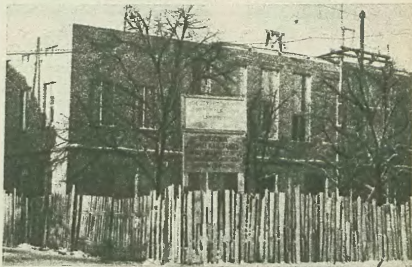
W Łęczycy jest prowadzona z funduszy SFOS budowa Domu Kultury
