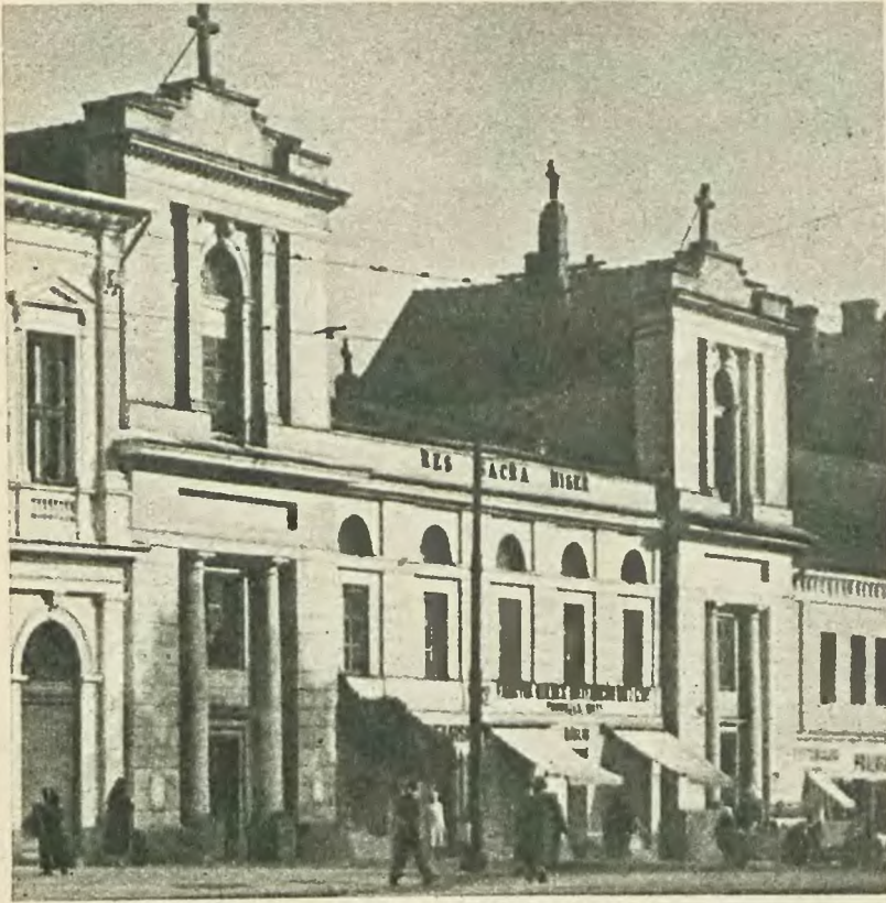
Część elewacji od Krakowskiego Przedmieścia zachowała się do 1939 roku w kształcie, nadanym jej przez Antoniego Corazziego.
