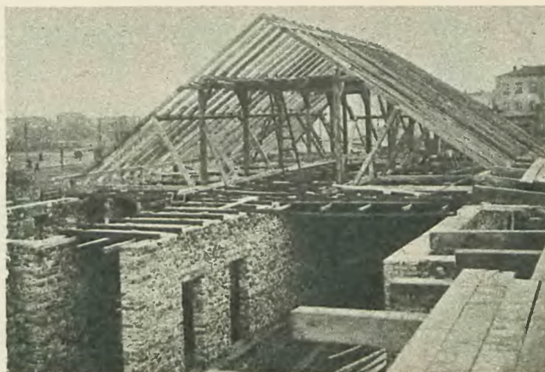
Przystąpiono już do pracy przy zakładaniu więźby dachowej.
