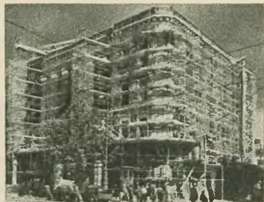
Tynkowanie domu na rogu bulwaru Józsefa świadczy o realizacji programu rządowego.
