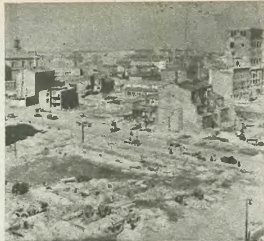
Widok terenu robót przy Pałacu. Patrzymy w kierunku zachodnim. Z lewej — kościół WW. Świętych, z prawej dom b. Cedergrena.
