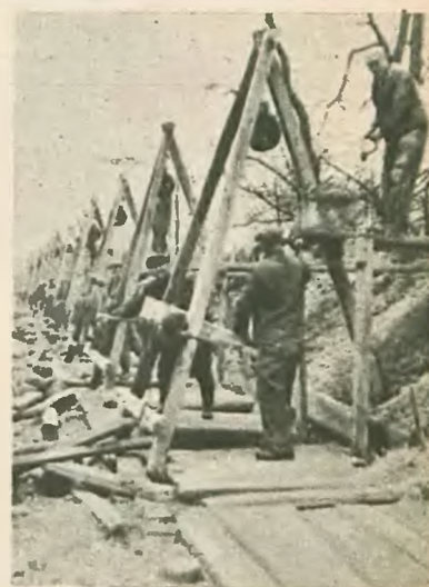
Budowa magistrali wodociagowej. Zdjęcia autora
