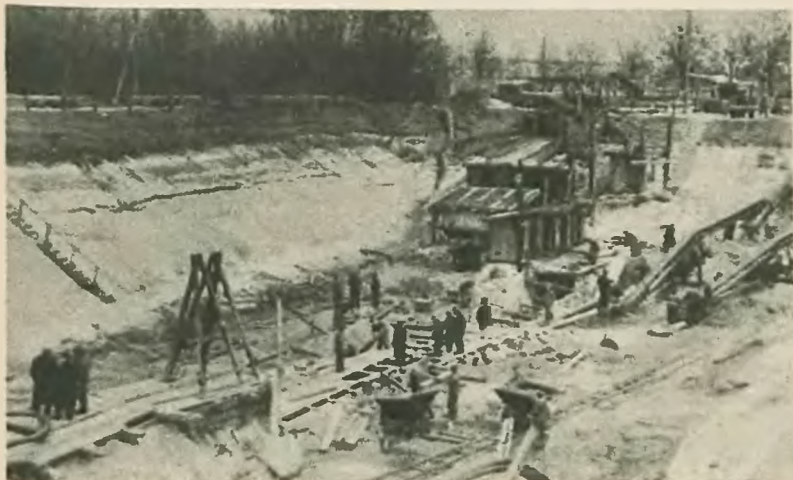
W tym olbrzymim wykopie będzie zmontowana stacja przepompowywania ścieków, która radykalnie naprawi stan sanitarny Grochowa.
