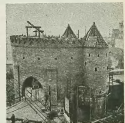
Stan prac przy budowie Barbakanu 2-go kwietnia 1954 roku. Fot. Z. Siemaszko
