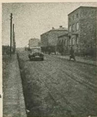
Nowa jezdnia ul. Kwiatowej.
