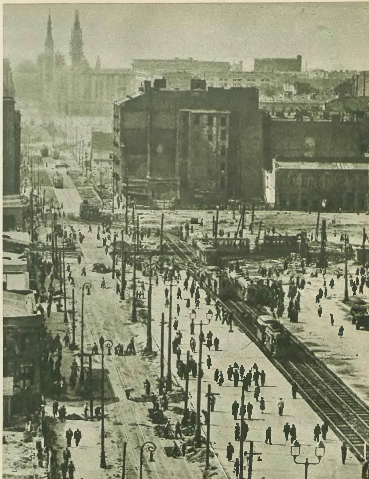
Skrzyżowanie Marszałkowskiej z alejami Jerozolimskimi w dniu 8-go lipca br. Zmontowano już gwiazdzisty rozjazd dla tramwajów. Oczyszczono narożnik, na którym stał niegdyś dom architekta Marcconiego. Dalej w kierunku placu Konstytucji widzimy wielką, ciemną bryłę kamienicy na rogu Zurawiej, która jest w stadium rozbiórki. Jeszcze dalej — gotowy dla przeprowadzenia nowej trasy teren, na którym stały przed 1939 r. czynszówki. Na planie ostatnim — domy pl. Konstytucji i kościół Zbawiciela. Fot. A. Funkiewicz
