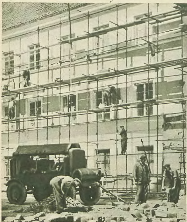
Przy rekonstrukcji domów zabytkowych stosujemy zwykle tynki. Fot. A. Kaczkowski
