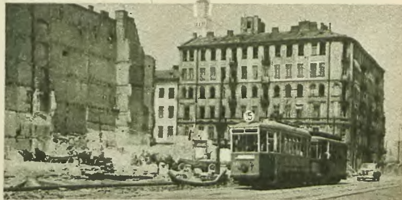
Obserwujemy właśnie wywożenie gruzu, pozostałego po resztkach „parterowej” Marszałkowskiej. Praca wre w całej pełni. Jest o tyle trudna, że ani na chwilę nie wstrzymano na tym odcinku ruchu tramwajów, ograniczono jedynie komunikację samochodową. Fot. F. Karasielwicz
