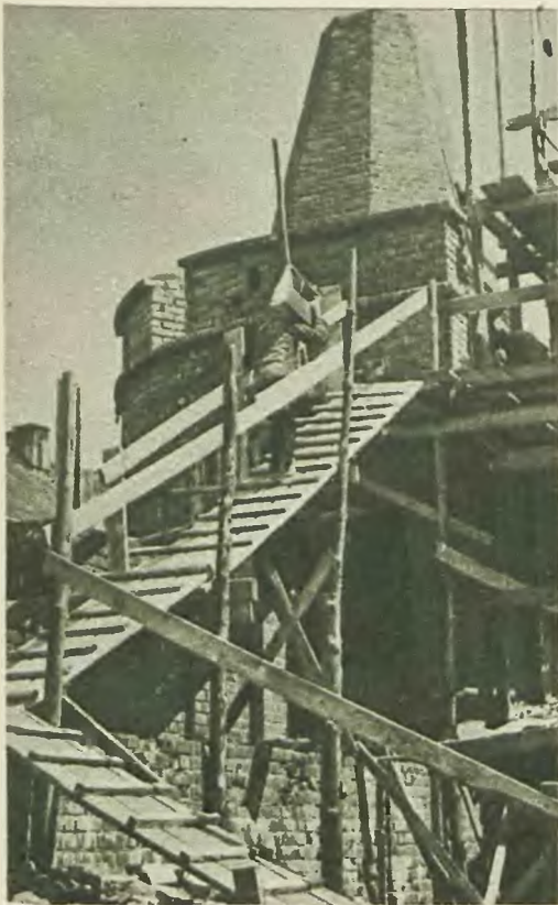
Baszta zwana „Prochową“ posiadała na rycinie Zygmunta Vogla spiczaste zakończenie. Obecnie, przywrócono je przy rekonstrukcji.
