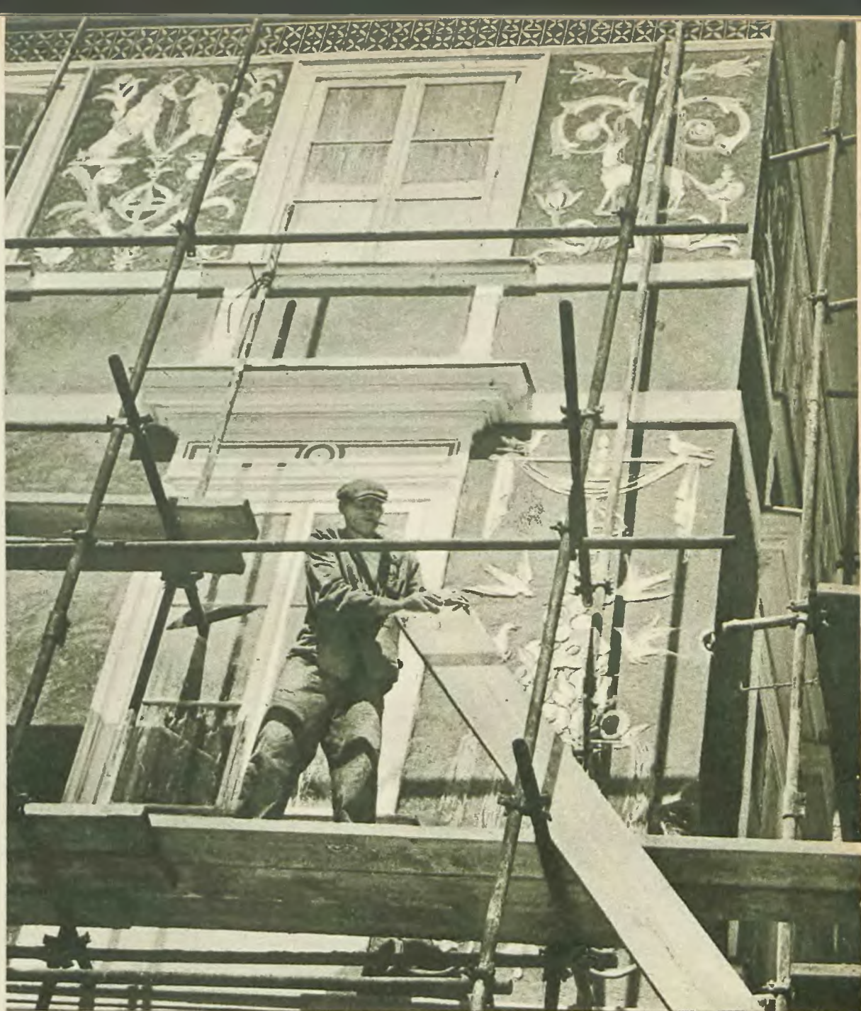
Ileż pracy wymaga wykończenie takiej elewacji! Ale jakże przyjemnie jest powiedzieć sobie: „Z tym — już koniec!“ i przystąpić do rozbierania rusztowań, na których się pracowało przez długie tygodnie. Oglądamy taką właśnie chwilę, przy jednym z domów przy ul. Freta. Fot. F. A. Kaczkowski
