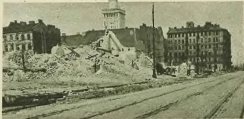
Z rogu ulicy Hożej i Marszałkowskiej (strona parzysta) oglądamy resztki kamienic między Hożą i Wspólną i wielką czynszówkę na rogu Zurawiej, która zostanie rozebrana, gdyż znalazła się na linii nowej, poszerzonej przeszło dwukrotnie, ul. Marszałkowskiej.
