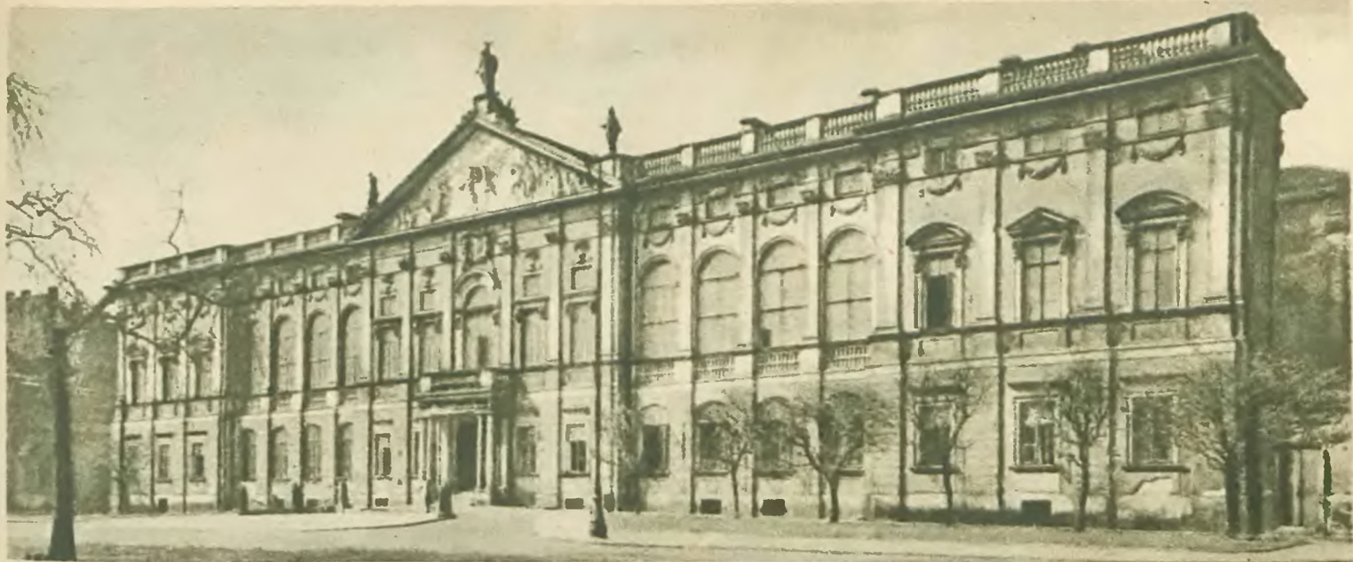
Pałac Krasińskich, jedno z najwspanialszych dzieł Tylmana, padł również ofiarą hitlerowskiej furii niszczenia (Zdjęcie z 1939)
