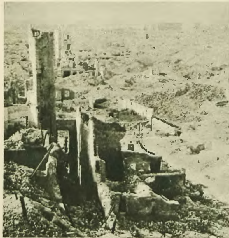
Muranów wchodził w granice getta i podzielił tragiczne losy tej dzielnicy, z której ogień i dynamit uczyniły rozległą pustynię.
