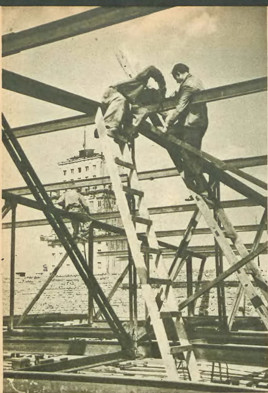
Montaż stalowych konstrukcji dachowych na gmachu Filharmonii. Przyszłe główne wejście będzie prowadziło od ulicy Sienkiewicza
