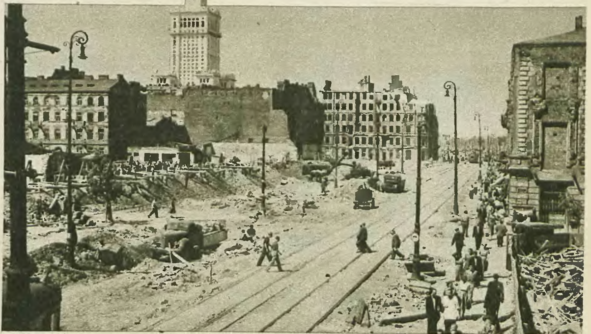
Stan budowy ulicy Marszałkowskiej w początku sierpnia 1954 roku.
