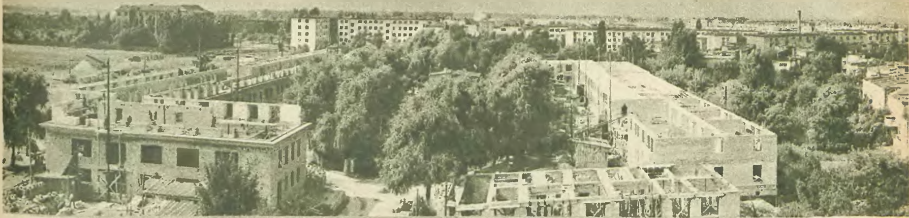
Przy ulicy Wyspiańskiego wyrasta nowe osiedle mieszkaniowe Żoliborza budowane wg projektów inż. arch. J. Nowickiego (Patrz tekst). Zdjęcia L. Jabrzemski
