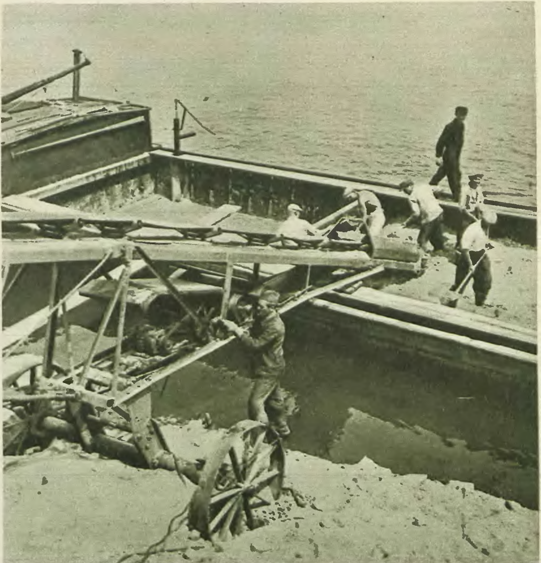
Piaskarze tworzą dziś zgrany z maszyną kolektyw ludzi pracujących coraz wydawniej. Fot. CAF
