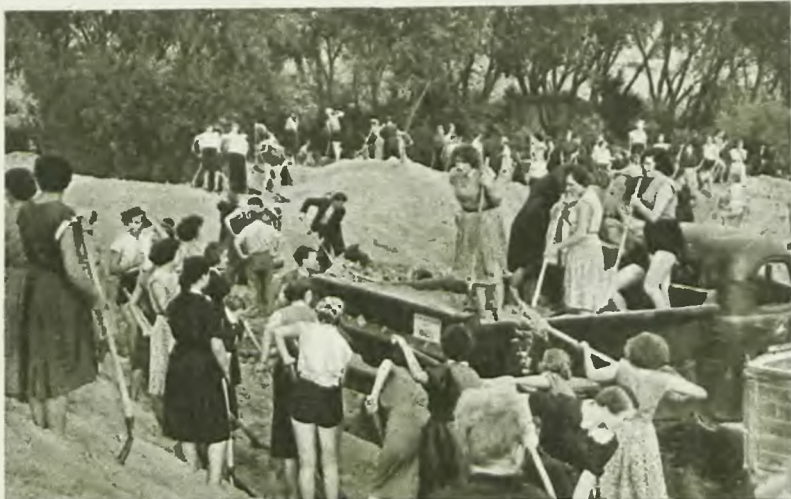
Przy budowie stadionu trzeba przerzucić i usypać setki tysięcy metrów sześciennych ziemi. Oto obrazek z pracy ochotników.
