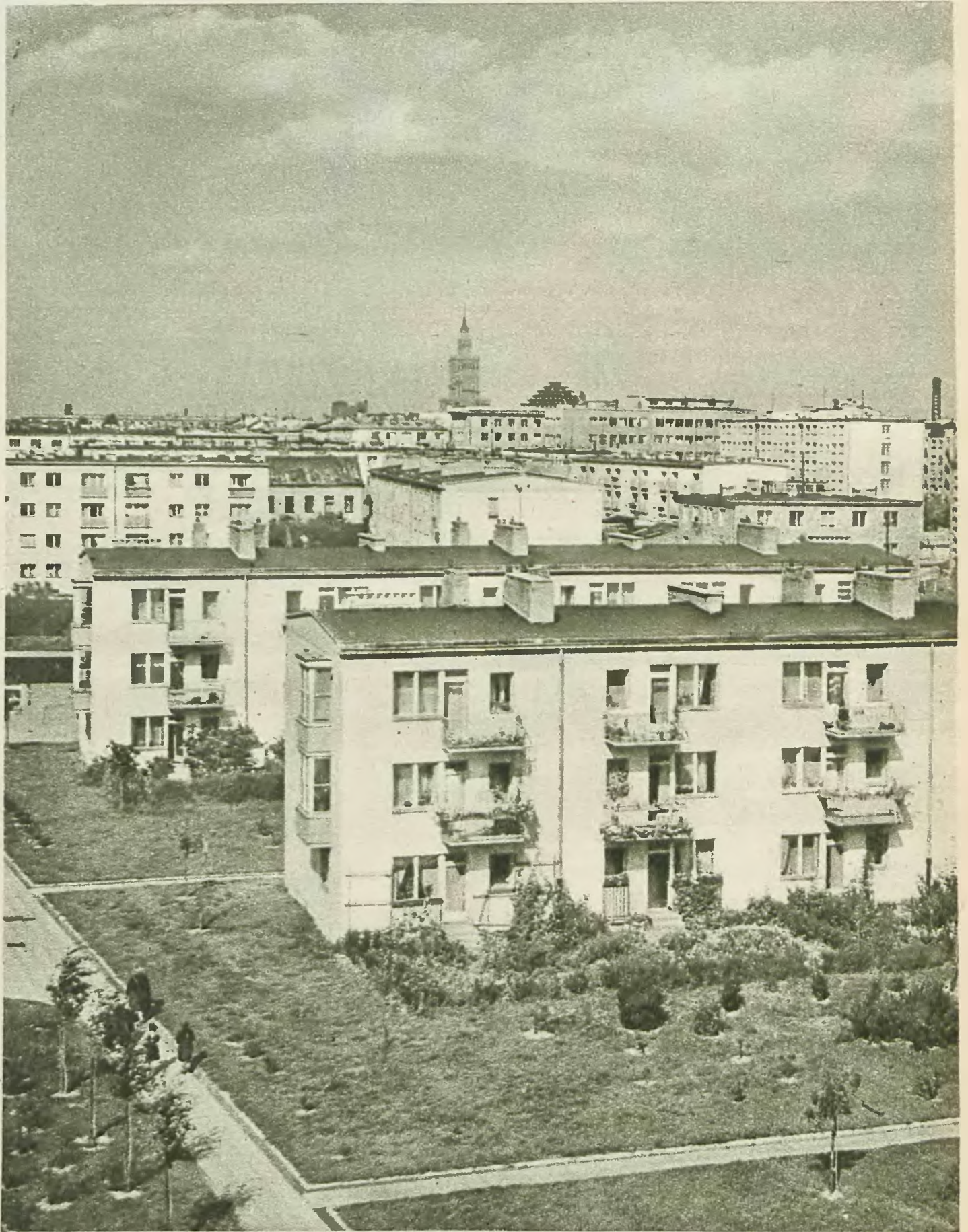
Fragment osiedla mieszkaniowego Mokotów, z widoczną w oddali sylwetą Palacu Kultury i Nauki oraz geometryczną kopułą centralnego budynku Szkoły Głównej Planowania i Statystyki. Inne panoramy Nowej Warszawy — wew. numeru.
